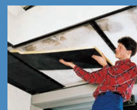
Montáž desek URSA® AKP 2/V do konstrukce podhledu
