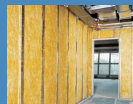
Izolace URSA GLASSWOOL® v konstrukci příčky
