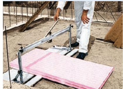
Příklad aplikace desek Perimetr pod základovou deskou
