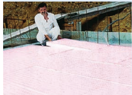
Příklad typického použití speciálních růžových desek v oblasti přechodu soklu na suterén
